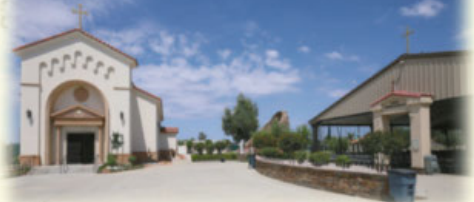
SHRINE/PAVILION / SANTUARIO/ PABELLON 4600 E. Brundage Ln., Bakersfield, CA 93307
